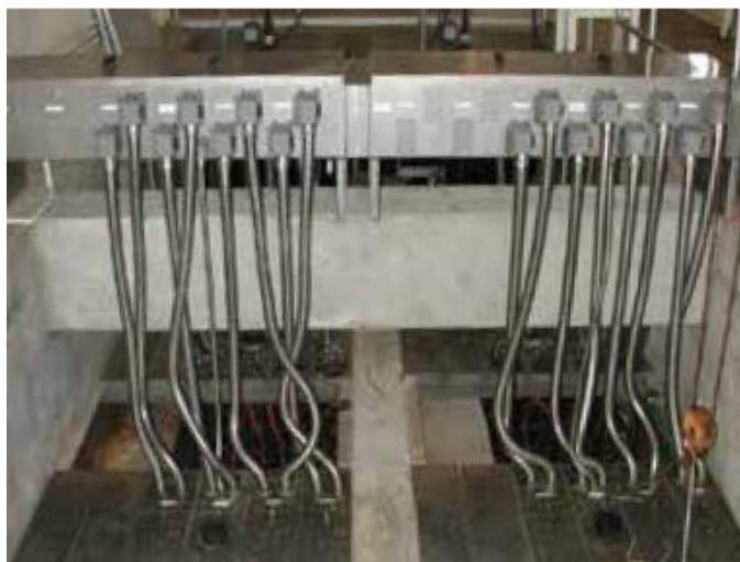
Figura 5. Sistema UV Carmel, dividido em dois canais paralelos.
